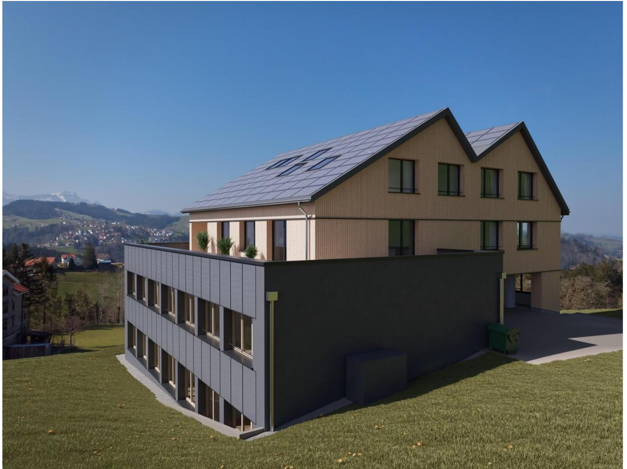
Die Dachform erinnerte an ein Fabrikshed und nimmt zusammen mit der Holzfassade des Neubauteils die traditionelle Bauweise des Ortes auf. Die Fassade des belassenen Gebäudeteils und das Dach wird vollumfänglich mit PV-Paneelen belegt, womit eine positive Energiebilanz und der Minergie-A Standard erreicht wird.
